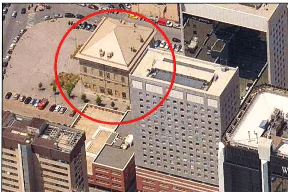
Vista aerea Est
